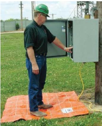
Equi-mat es la manera fácil de establecer una zona equipotencial para operadores eléctricos. Fácil de transportar, usar y almacenar. Consiste de un cable trenzado de cobre de alta ampacidad, cosido en forma de red sobre una tela de poliéster. El kit completo permite conectarse en paralelo con la tierra eléctrica y el componente en el cual se trabaja y pudiera ser energizado accidentalmente (tablero, interruptor, vehículo de servicio, cámara subterránea, etc.)
