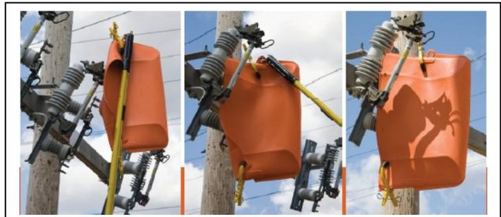
Use broches de sujeción para mantener y sujetar cobertores en lugar.
