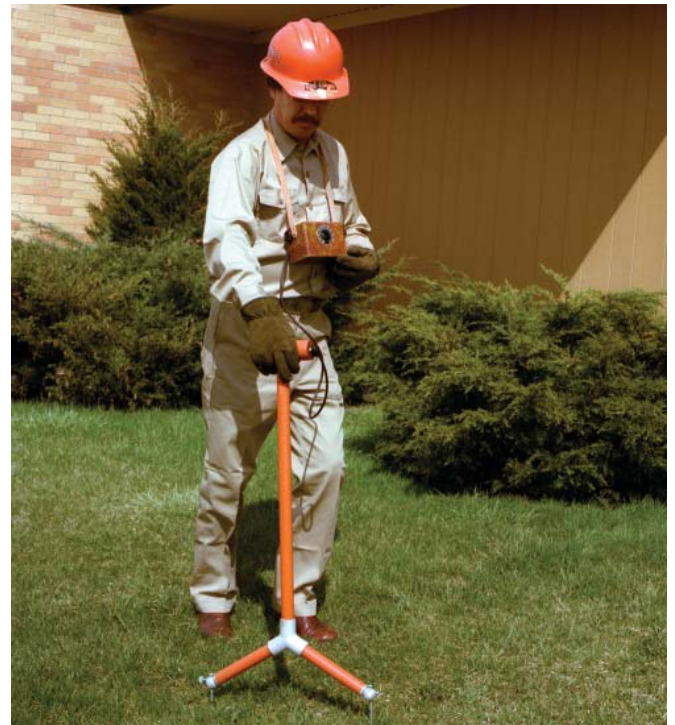
Localización de la falla.
