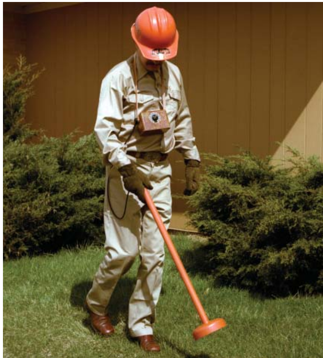
Localización de un cable subterráneo (No. de Cat. T403-0572)
